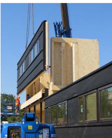
52 Holz-Modulbauweise als Prinzip für Mehrgeschosser
