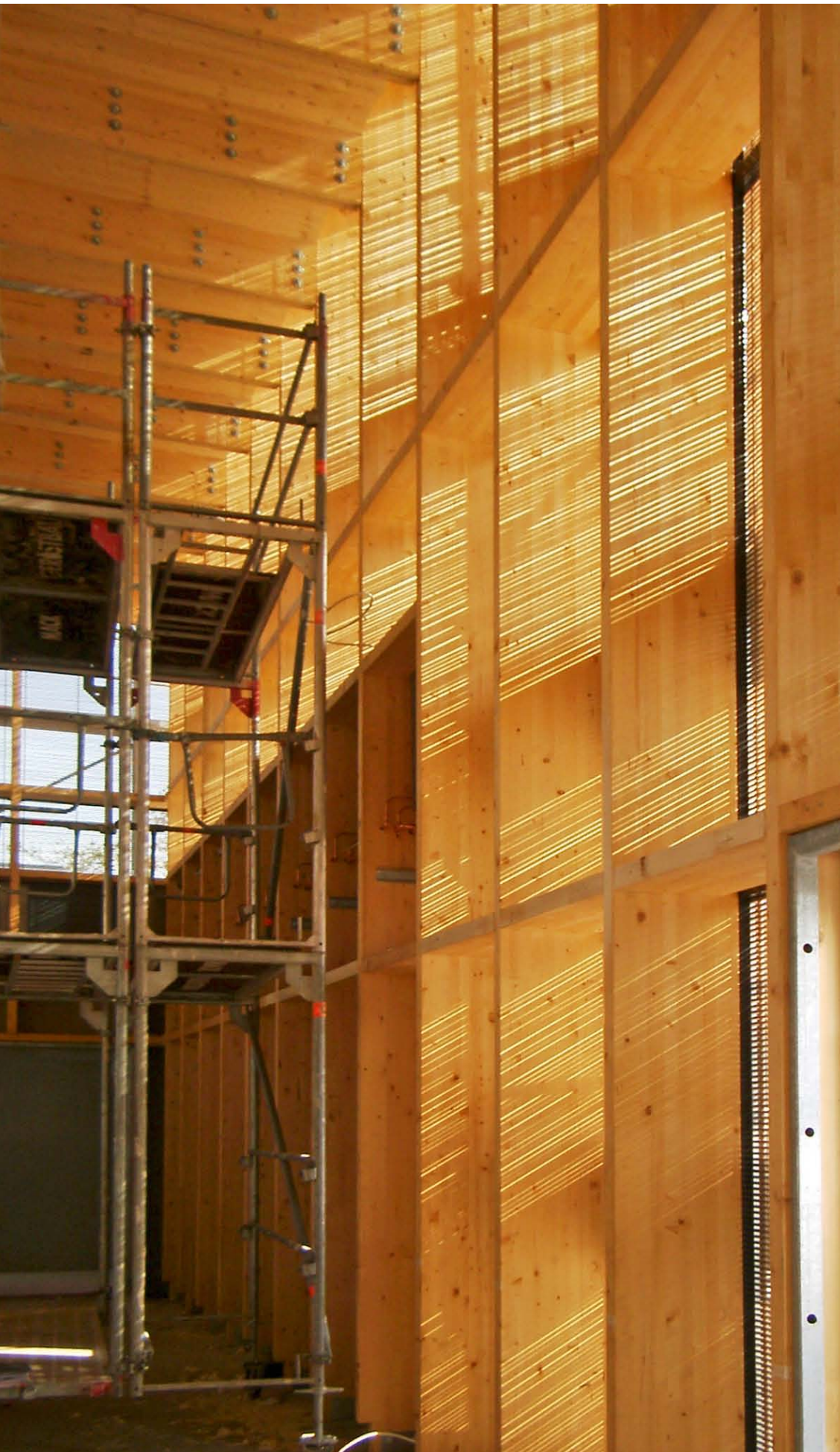
Holzbau im Halleninneren: Feine Merantiholz-Lamel- len schützen vor Blicken von außen Foto: Eckhard Ernst
