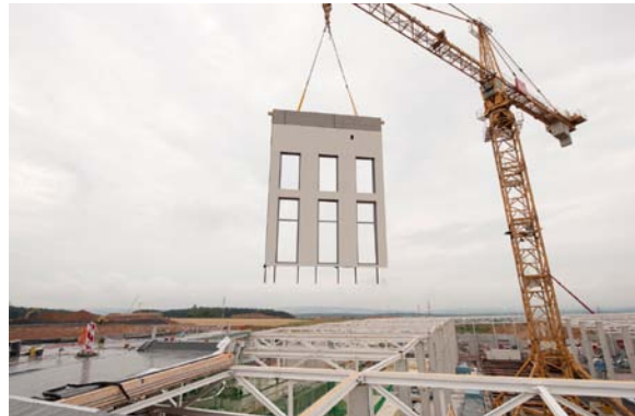
Montage der vorgefertigten Dach- und Wandelemente
