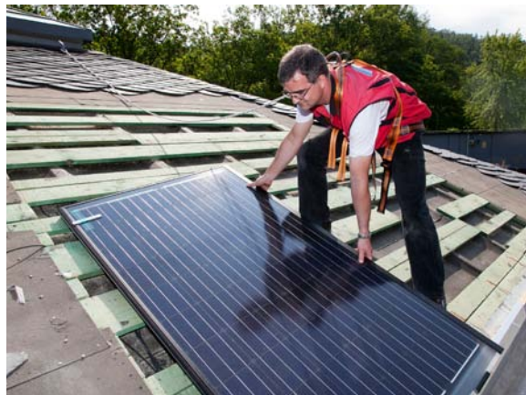
Die Montage des Easy-In Indach-Solarsystems beginnt mit dem Auflegen des ersten Solarmoduls links unten. Dabei wäre es auch möglich, die Montage auf der anderen Seite der Anlage zu beginnen. Das erste Modul wird positioniert und dabei mit dem oberen Ende in die Dachlatung eingehängt Foto: Solarwatt AG
