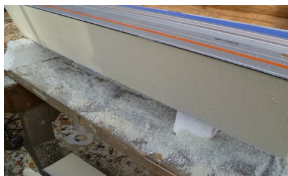
Zugeschnittener PUR Hartschaum – exakter Schnitt an der Führungsschiene entlang
