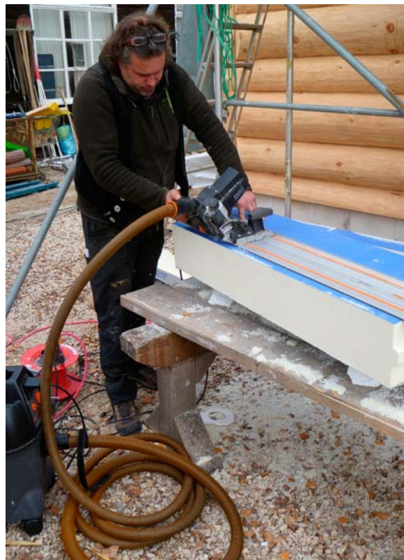
Zuschnitt von PUR Hartschaum mit der UniverS mit 200 mm Schnitttiefe. Dank Führungsschiene gibt es exakte Schnitte, die Säge gleitet mühelos durch das Material Fotos: Protool
