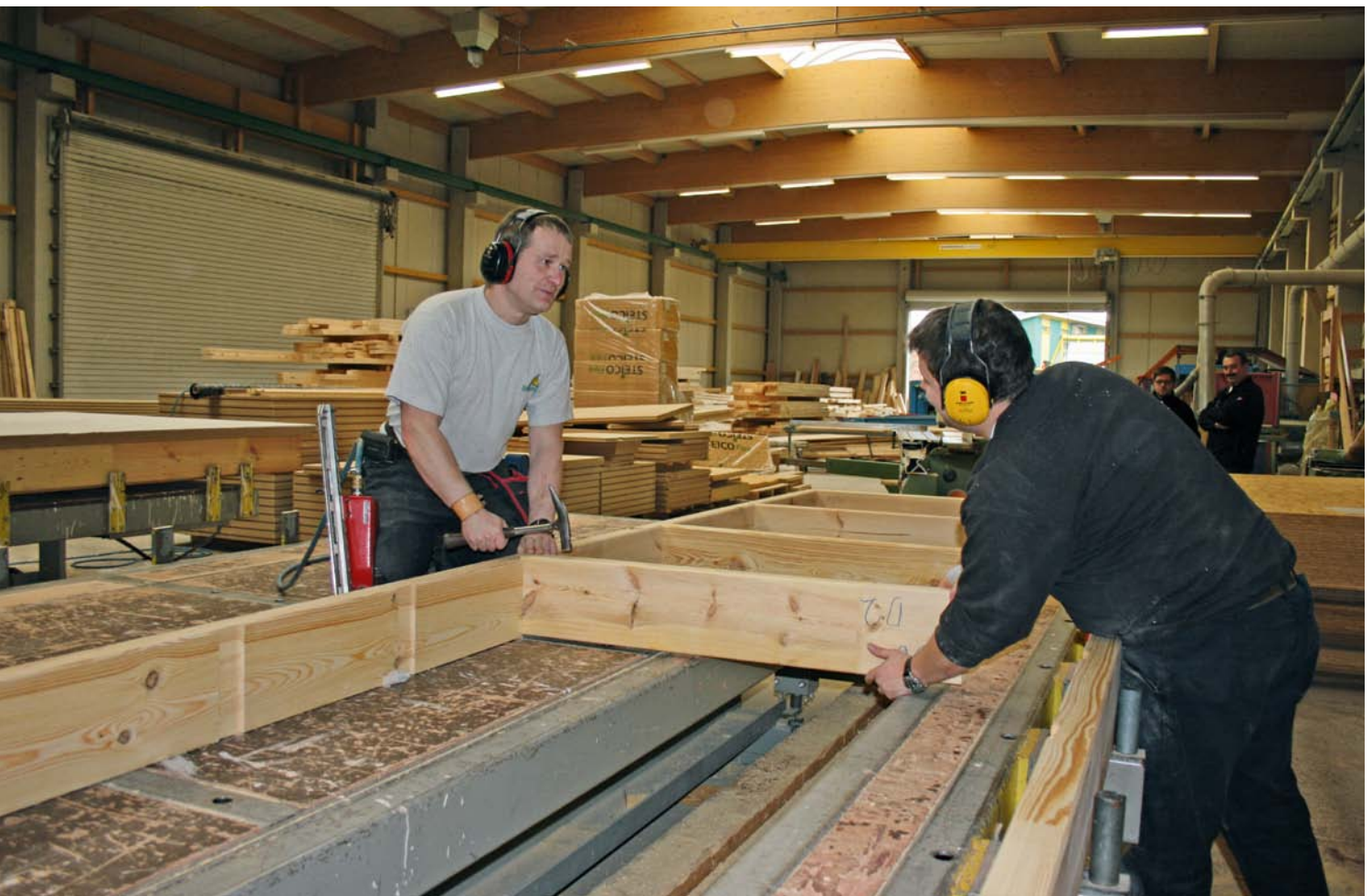
Alexander Canje (links) und Hannes Ilgenfritz fügen in der Werkhalle eine Holzständerkonstruktion zusammen Foto: Birgit Althof
